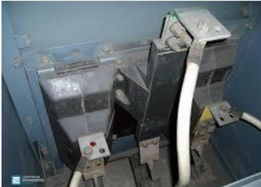
es CT interior, ubicado dentro Tablero de distribución o disyuntor, generalmente se encuentra en la barra colectora inferior que luego se conecta al disyuntor con el fin de completar el circuito para que pueda conectarse fácilmente con el cable entrante o saliente.
